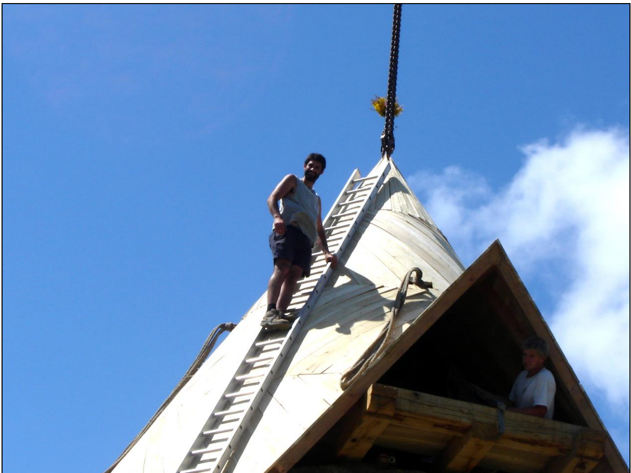
La pose du bouquet final au sommet du toit
