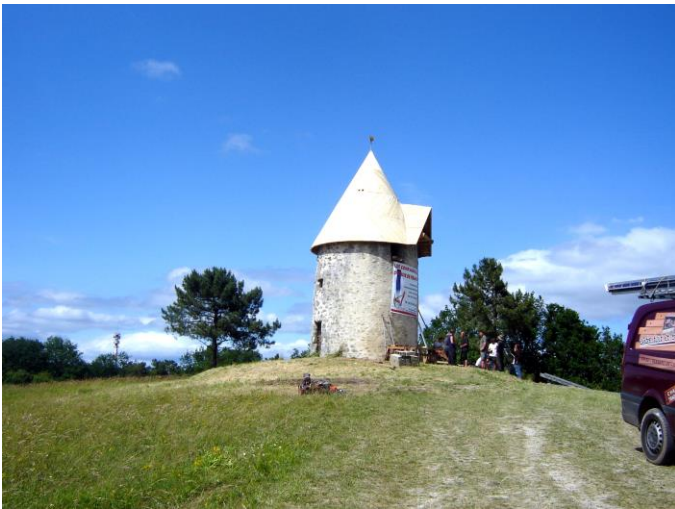
Le chantier se termine
